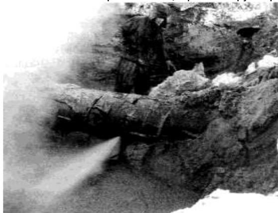
*Рис. 2.21. Свищ в трубопроводе*
