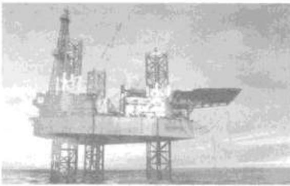
Рис. 2.70. Самоподъемная буровая установка
