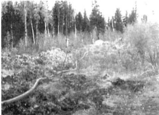
Рис. 2.43. Наземная укладка ГПМТ
