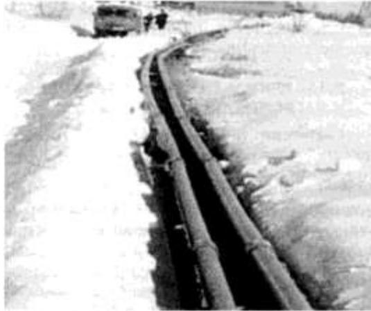
Рис. 2.44. Трубопровод из бипластмассовых труб
