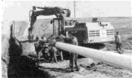
Рис. 2.42. Нанесение внешних изоляционных покрытий труб в полевых условиях
