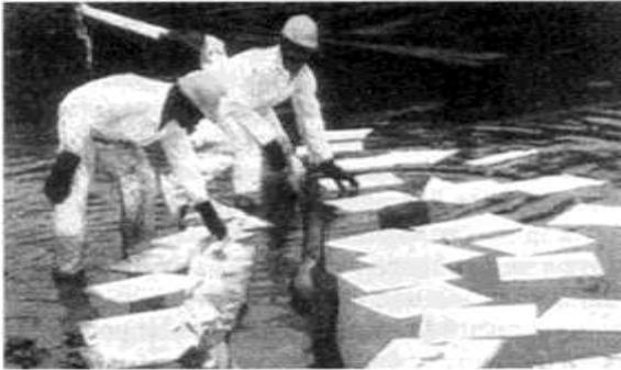
Рис. 2.94. Удаление нефти с помощью сорбентов
