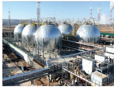
Объект уникален размерами шаровых резервуаров для хранения аммиака и уровнем примененных технологических решений.
