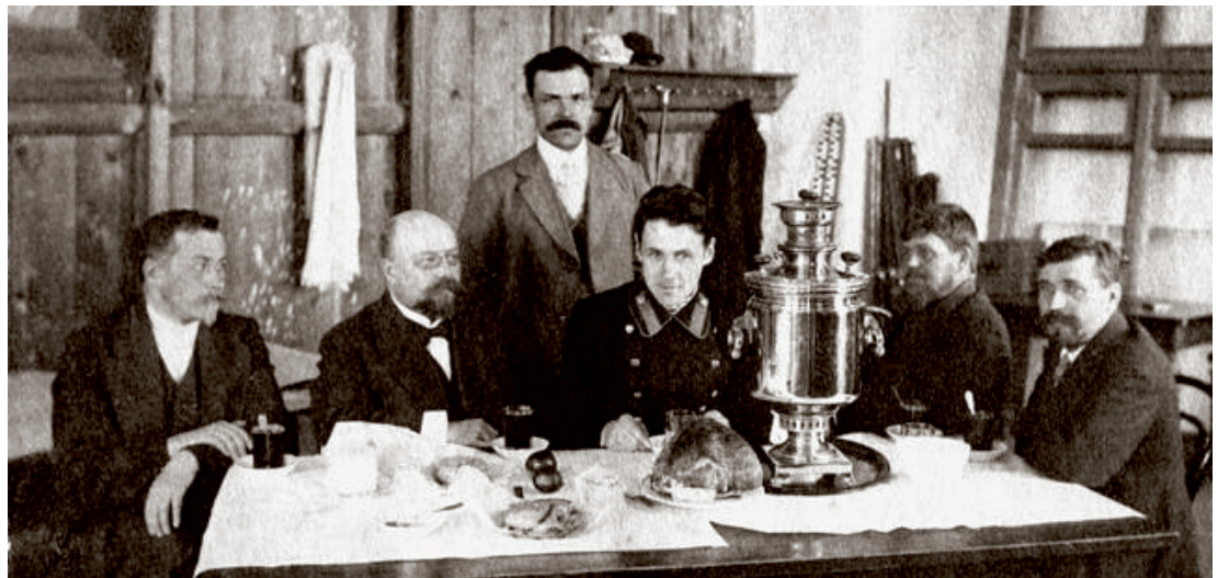
В конторе строительства учебного городка.
