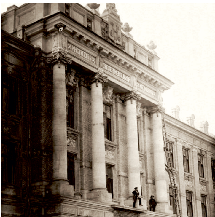
Отделка фасада I корпуса
