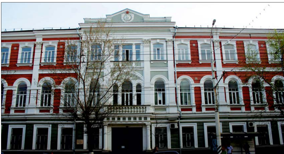
Особое внимание в этот период уделялось обновлению учебных помещений. В рамках капитального ремонта был возрождён VI корпус – памятник архитектуры местного значения.
