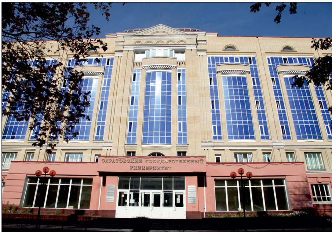
Новый, XII учебный корпус общей площадью более 23 тысяч квадратных метров вместил не только современные аудитории, лаборатории, офисные помещения, но и прекрасные актовый и спортивный залы.
