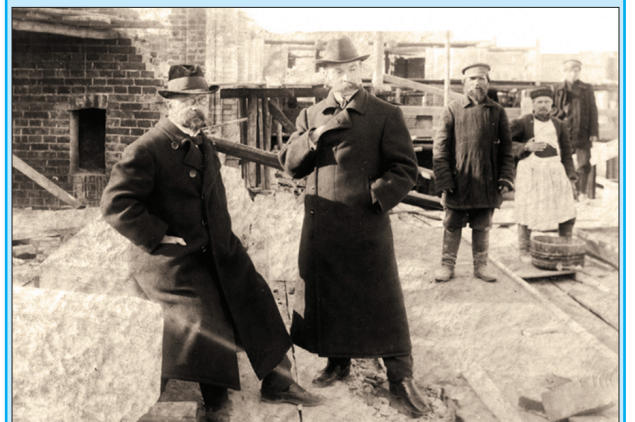
Строительство I корпуса. Архитектор К.Л. Мюфке (слева) и помощник архитектора В.Д. Караулов. Фото 1910 г.
