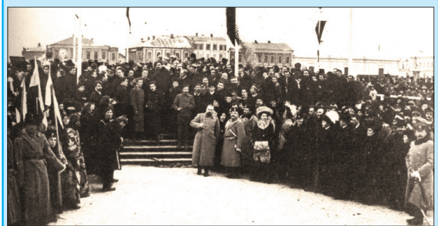
Закладка здания института экспериментально-медицинских наук на Московской площади. Фото 6 декабря 1909 г.
