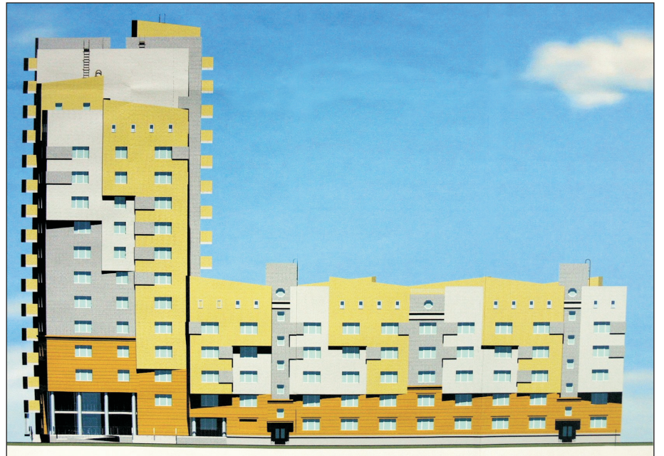
Общежитие СГУ (ул. Кутякова, 144). Начало строительства – 2007 год. Окончание строительства – 2009 год.
