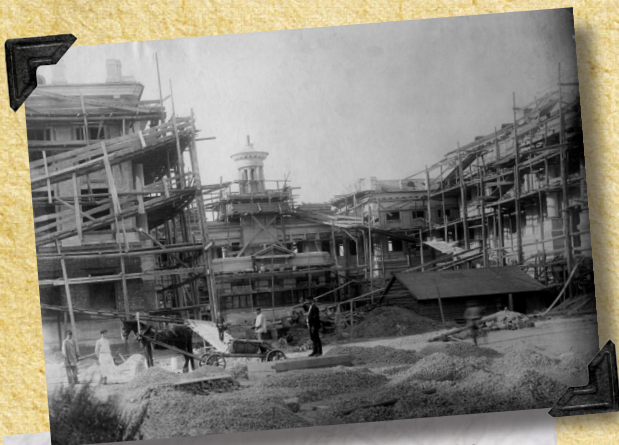
1912 год. Рабочие, домик для их отдыха, груды песка, конная повозка... Полным ходом идёт строительство университета.
