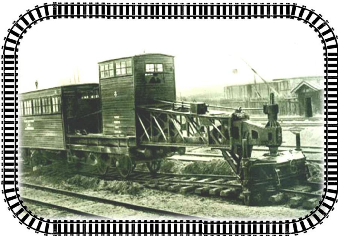
**Машина для путевых работ конструкции Бузарева рихтует,
