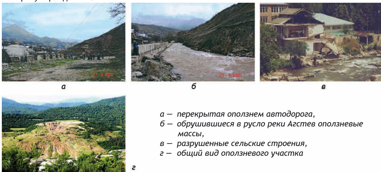
Рис. 3. Современная ситуация на участке Агарцинского оползня
