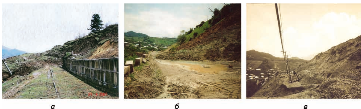
Рис. 2. Разрушенная оползнем железная дорога (а), перекрытые сползшими массами полотно железной дороги (б) и обходная автомобильная дорога (в) [3]
