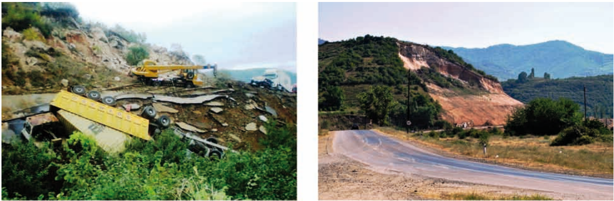
а б Рис. 7. Ситуация в октябре 2011 г. на участке Айрумского оползня (а) и современная обстановка (б)
