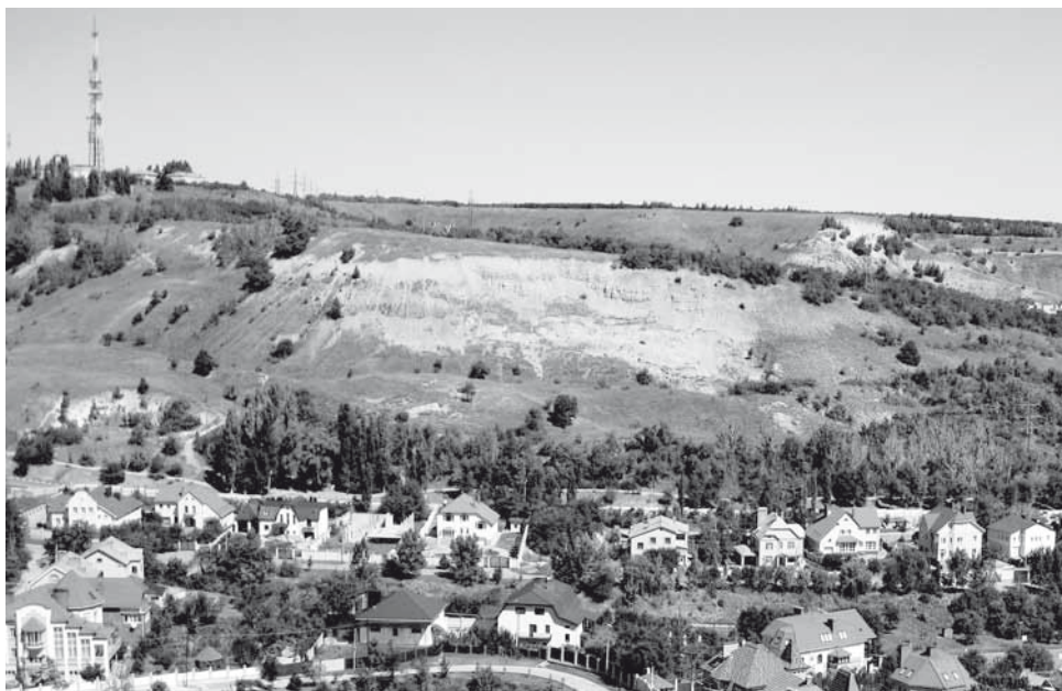
Рис. 1. Общий вид на верхний оползень левого борта Октябрьского ущелья (август 2011 г.)
