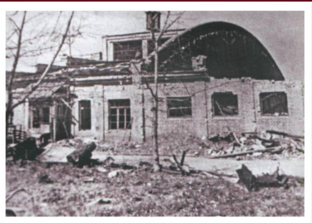
Ремонтно-механический цех Крекинг-завода после авианалета. 1942 год
