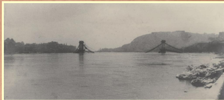
Венгрия. Взорванный немцами мост через Дунай в г. Будапеште
