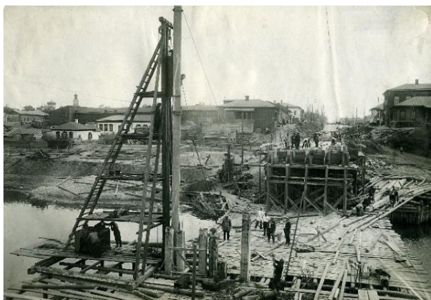
Рис. 5. Установка опор
