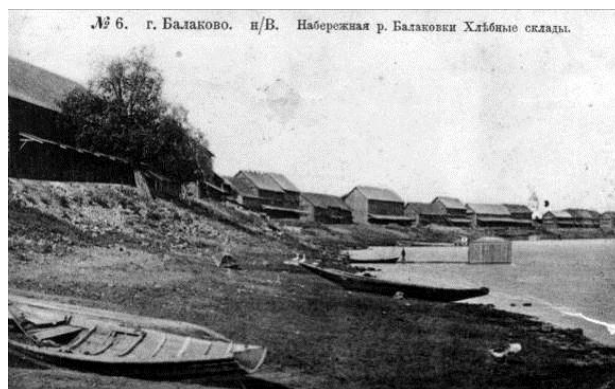
Рис. 3. Хлебные склады на Набережной реки Балаковки.
