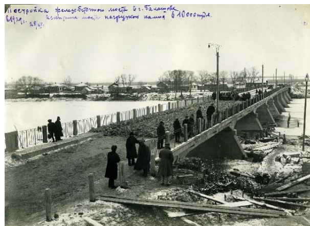
Рис. 6. Испытание нагрузкой
